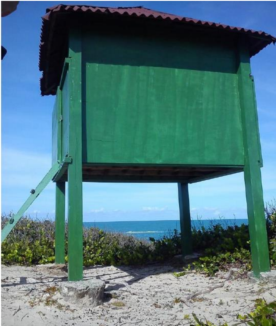
FIGURA 5 - Observatório (Ponto Fixo)
